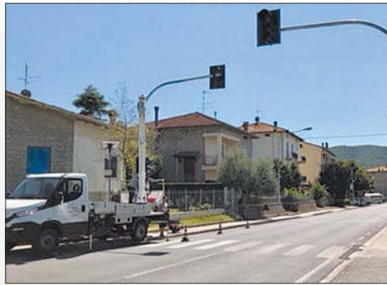
Lavori in corso | I semafori saranno attivi nei prossimi giorni
